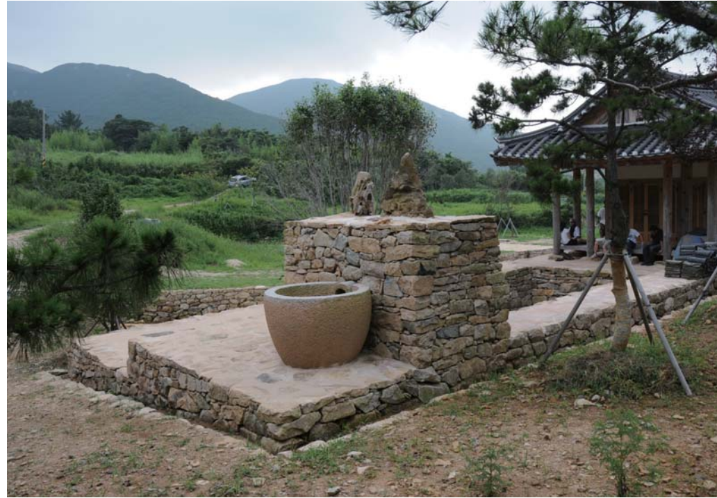
전통유적의 복원. 부용동 곡수당 상지 입수장치로 잘못 복원된 것으로 판단되는 물학과 석제비구. ©성중상. 2008. 8월과 2007. 12월 촬영. 물을 인근 계류에서 끌어오면서 가산을 조성하고 그 밑에 은통으로 물을 대던 전통적 수경처리기법은 온데간데없고, 느닷없는 원형 물학과 석축단, 그리고 석제비구를 만들었다.
